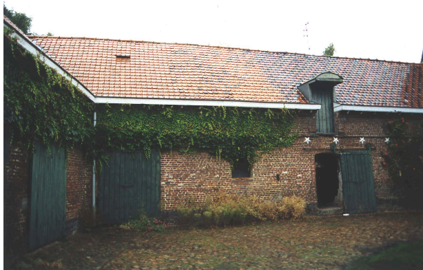
Des portails en bois coulissants rythment les façades
