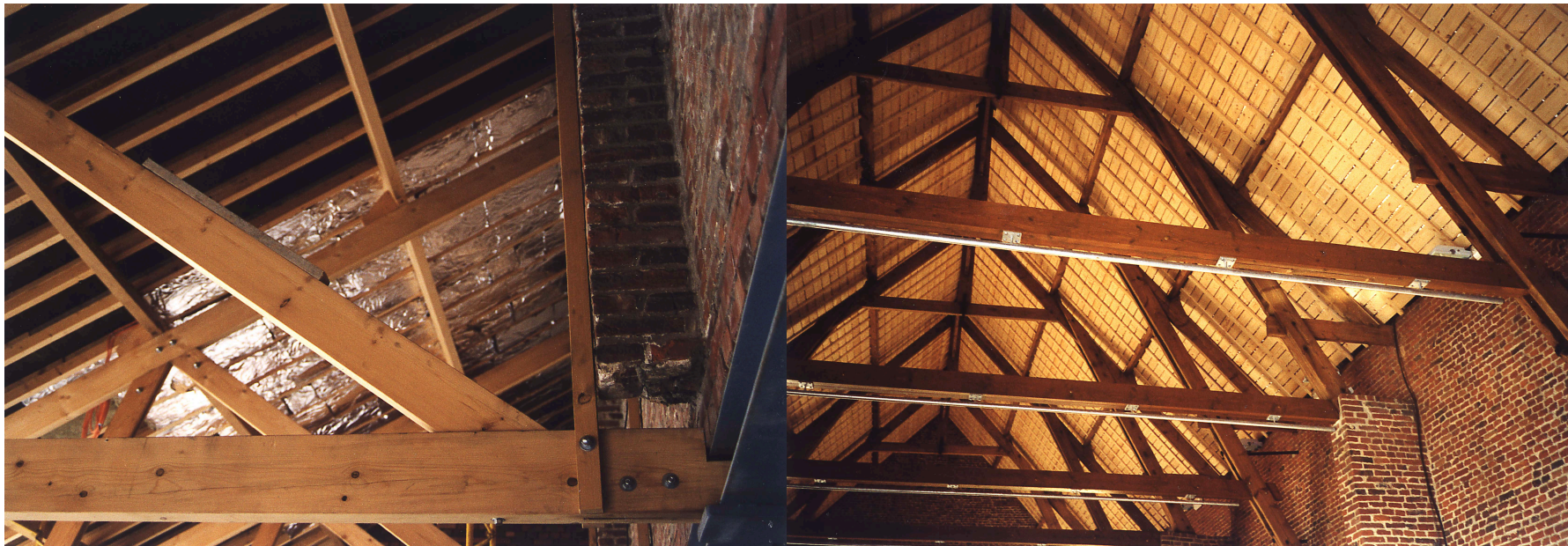
L'isolation de la grande salle. Le pare vapeur brillant visible entre le platelage disjoint reconstitue le mystère qui était induit par des éclats de lumière entre les tuiles.
