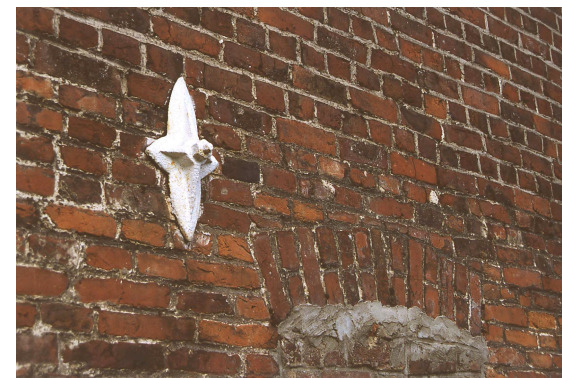
Cabochon et boulon visibles en façade.
