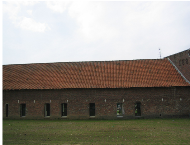
Sur l'extérieur, les eaux pluviales alimentaient les douves.
