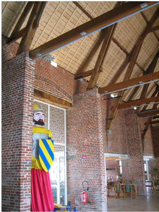
La charpente de la grande salle restaurée
