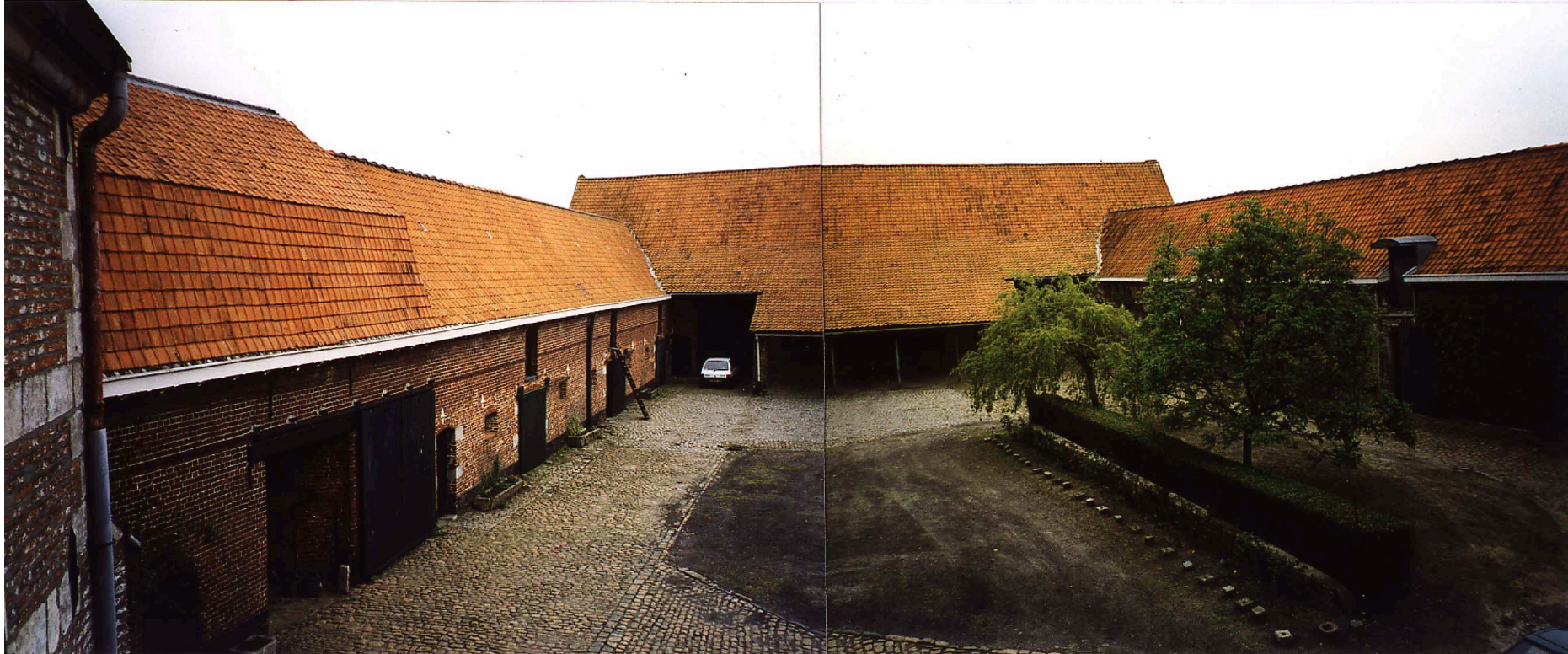
Etat de la cour avant travaux.
