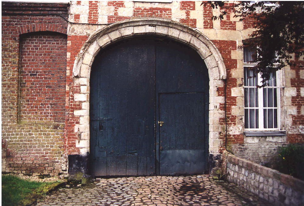
Le portail en bois irrécupérable a été remplacé par un grille métallique.
